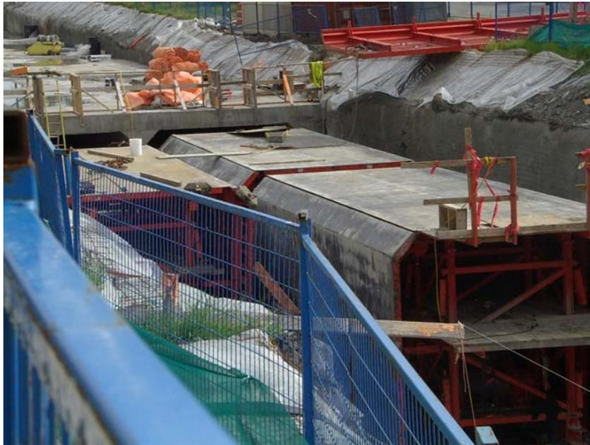
Figure 3-3 : Exemple de construction en tranchée couverte – Skytrain de Vancouver (2)
