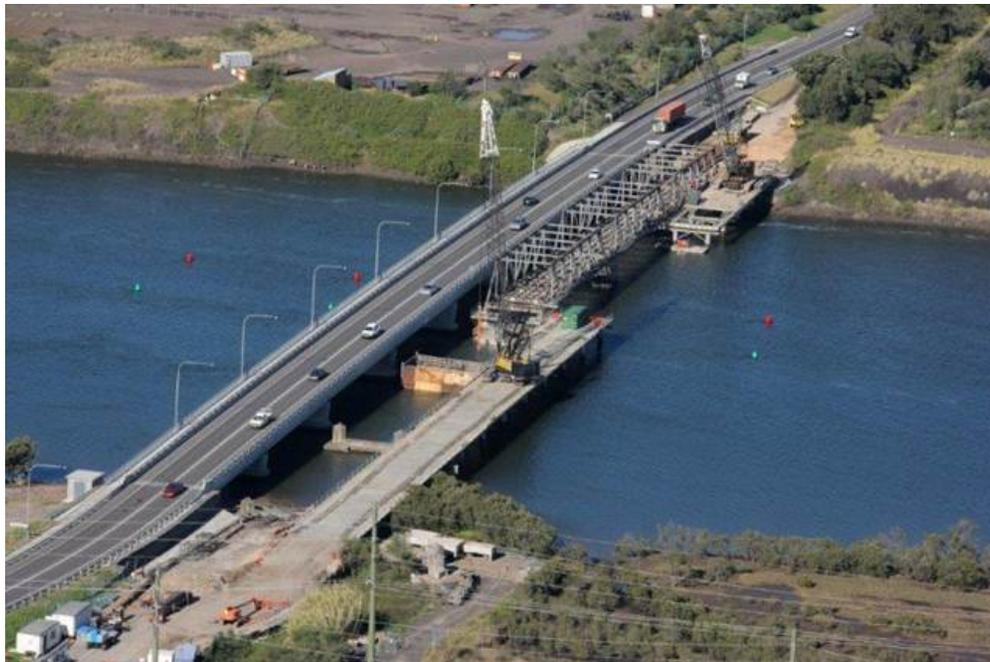
Figure 3-17 : Exemple de construction avec plateforme sur pieux (Newcastle, Australie)
