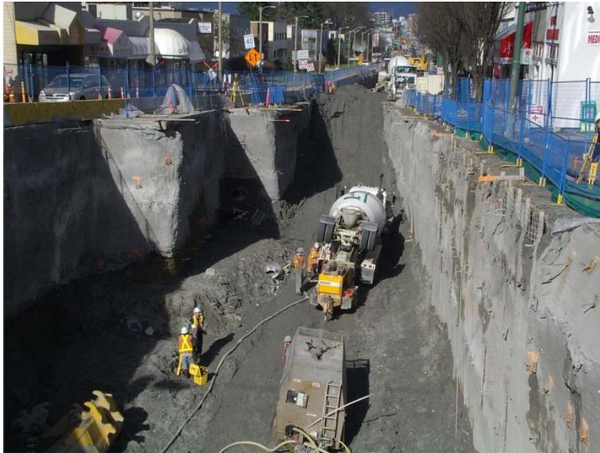
Figure 3-5 : Exemple de construction en tranchée couverte – Skytrain de Vancouver (4)
