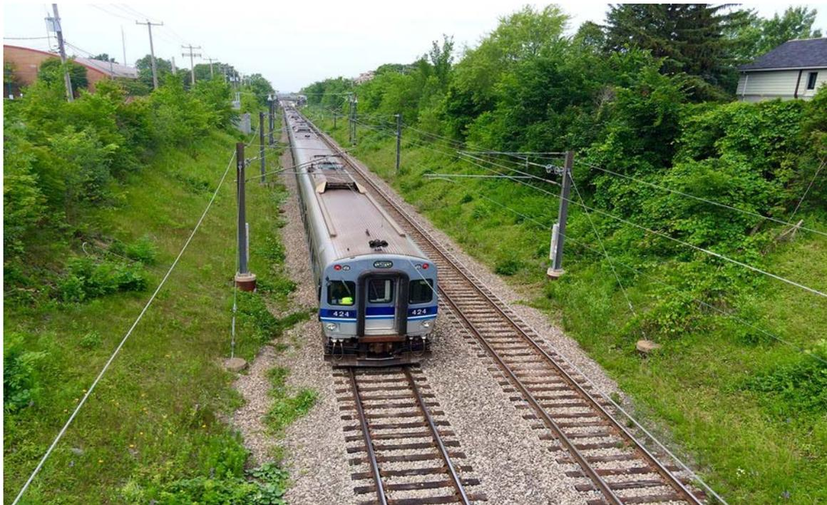
Figure 2-12 : Exemple de voie ballastée double (Deux Montagnes entre la gare Bois-Franc et la Gare Centrale)
