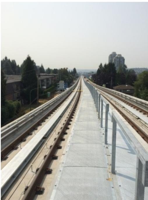
Figure 4-1 : Exemple de chemin d'évacuation tracé en surélevé (Evergreen Line - Vancouver)
