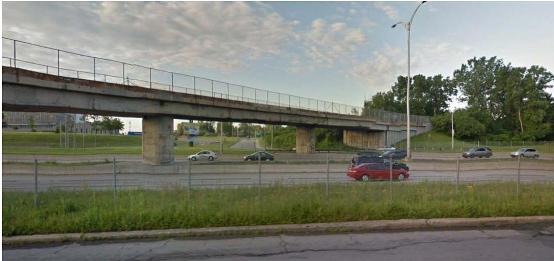
Figure 2-18 : Exemple d'étagement de voie ferrée
