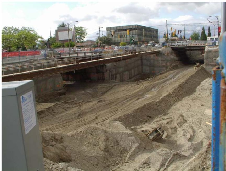
Figure 3-4 : Exemple de construction en tranchée couverte – Skytrain de Vancouver (3)
