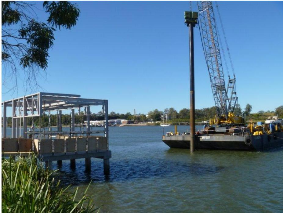
Figure 3-15 : Exemple de construction avec barge pour forage de pieu (Northshore, Hamilton)
