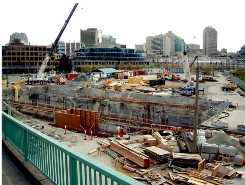
Figure 3-2 : Exemple de construction en tranchée couverte – Skytrain de Vancouver (1)
