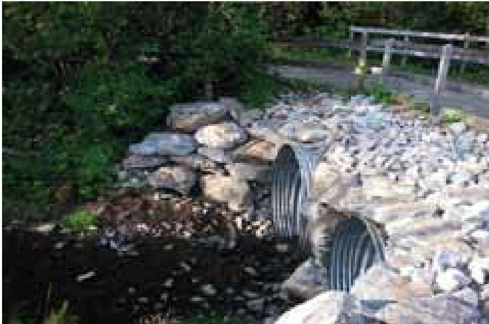
Figure 3-18 : Exemple de construction avec remblai et ponceaux
