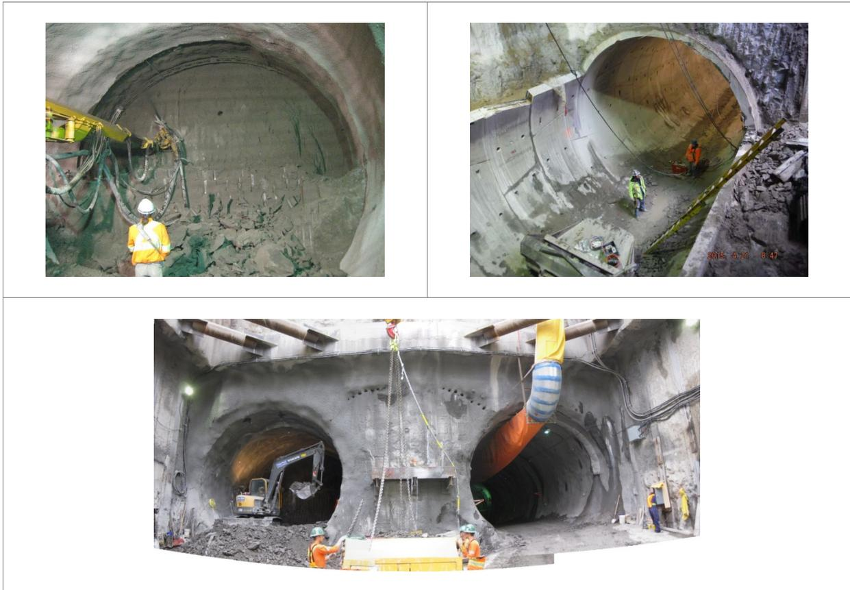
Figure 3-12 : Technique d'excavation conventionnelle à partir du puits
