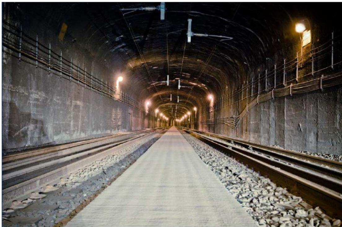
Figure 2-42 : Tunnel Mont-Royal – voûte simple et trottoir d'évacuation central
