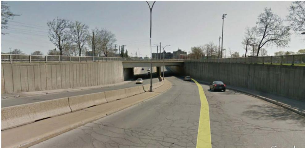
Figure 2-15 : Exemple d'étagement inférieur de la route sous la voie ferrée
