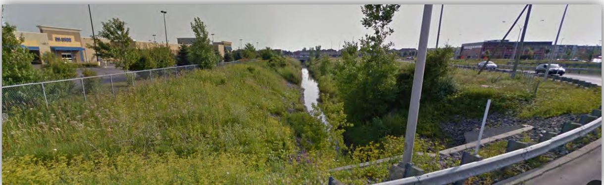
5. Fossé Daigneault à l'angle de la bretelle de l'A10 — Vue en direction sud-ouest (Google 2015, Street View, Juil. 2014).
