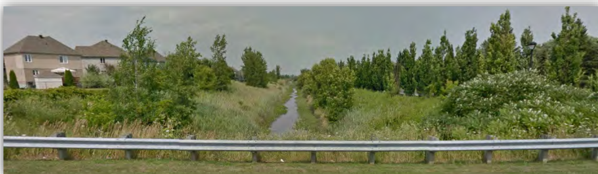
3. Fossé Daigneault à l'angle du boulevard Lapinière — Vue en direction Nord-est (Google 2015, Street View, Juil. 2014).
