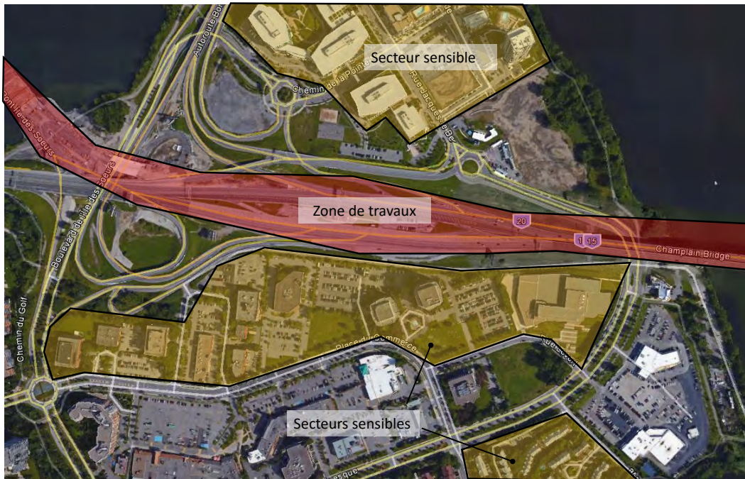
Figure 4: Secteurs sensibles (jaune) entourant la zone des travaux (rouge) (Source: Google Earth V 7.1.5.1557. (17/9/2013). Ville de Montréal, Canada. 45°28'35.66"N, 73°32'53.99"O, Altitude: 1.25 km.
