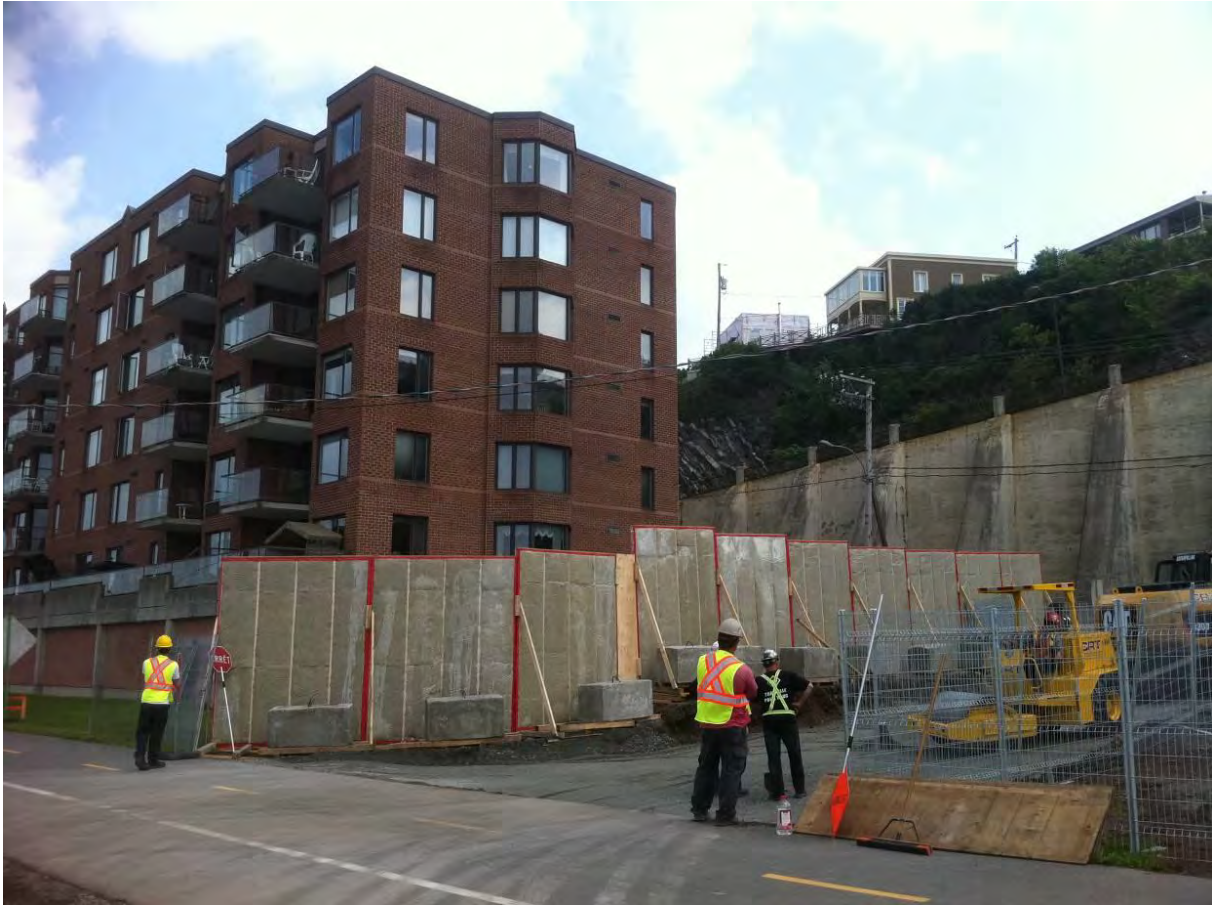
Figure 9: Exemple d'écran acoustique d'un projet de construction
