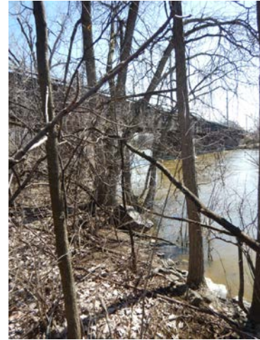
Vue de la rive nord du pont, à l'ouest du rail existant, faisant face à l'est
