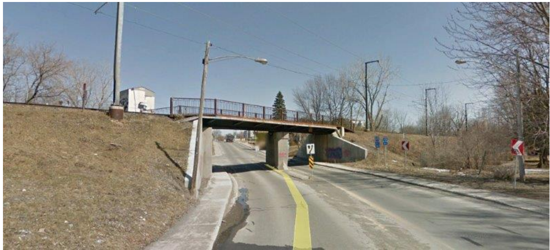
Figure 7-24 : Ouvrage d'art - pont d'étagement rue du Bord-de-l'eau
