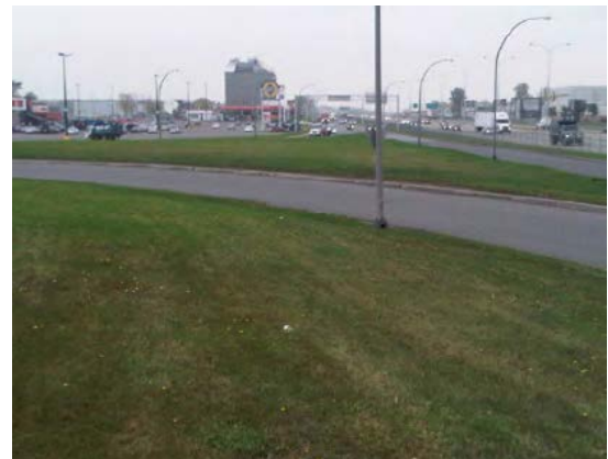
Espace gazonné et entretenu (bretelle de l'autoroute 40)
