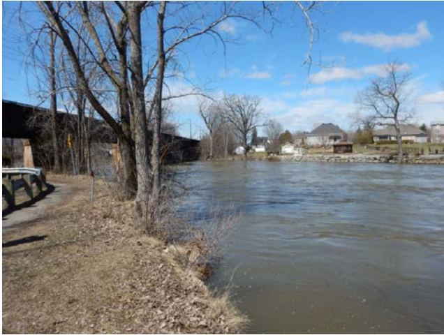
Vue de la rive sud du pont, à l'est du rail existant, faisant face au nord
