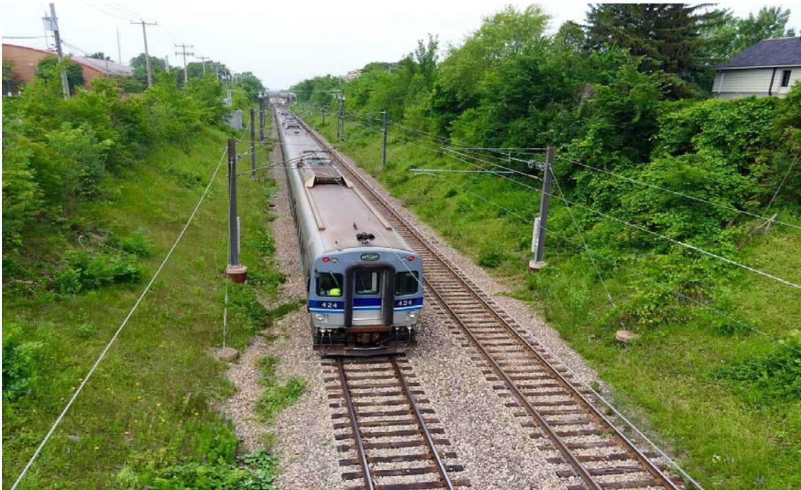
Figure 7-11 : Exemple voie ballastée double (Deux Montagnes entre la gare Bois-Franc et la Gare Centrale)
