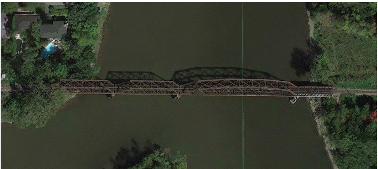
Figure 7-54 : Section 2 - Pont de la rivière des Prairies
