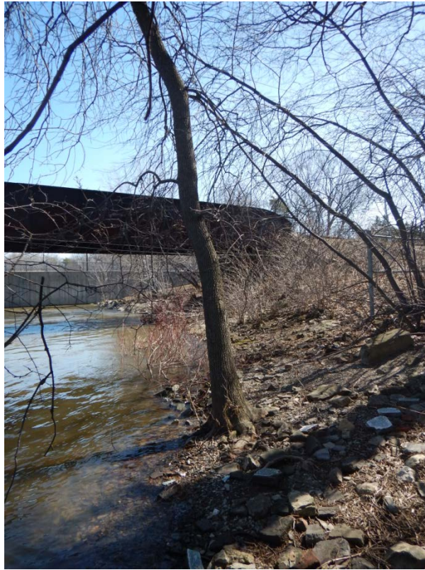
Photographie 5-14 : Vue de la rive sud du pont traversant la rivière des Mille-Îles (antenne Deux-Montagnes)
