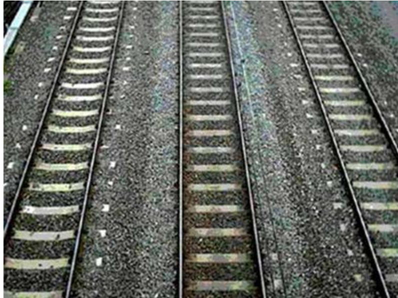
Figure 7-45 : Travaux au sol
