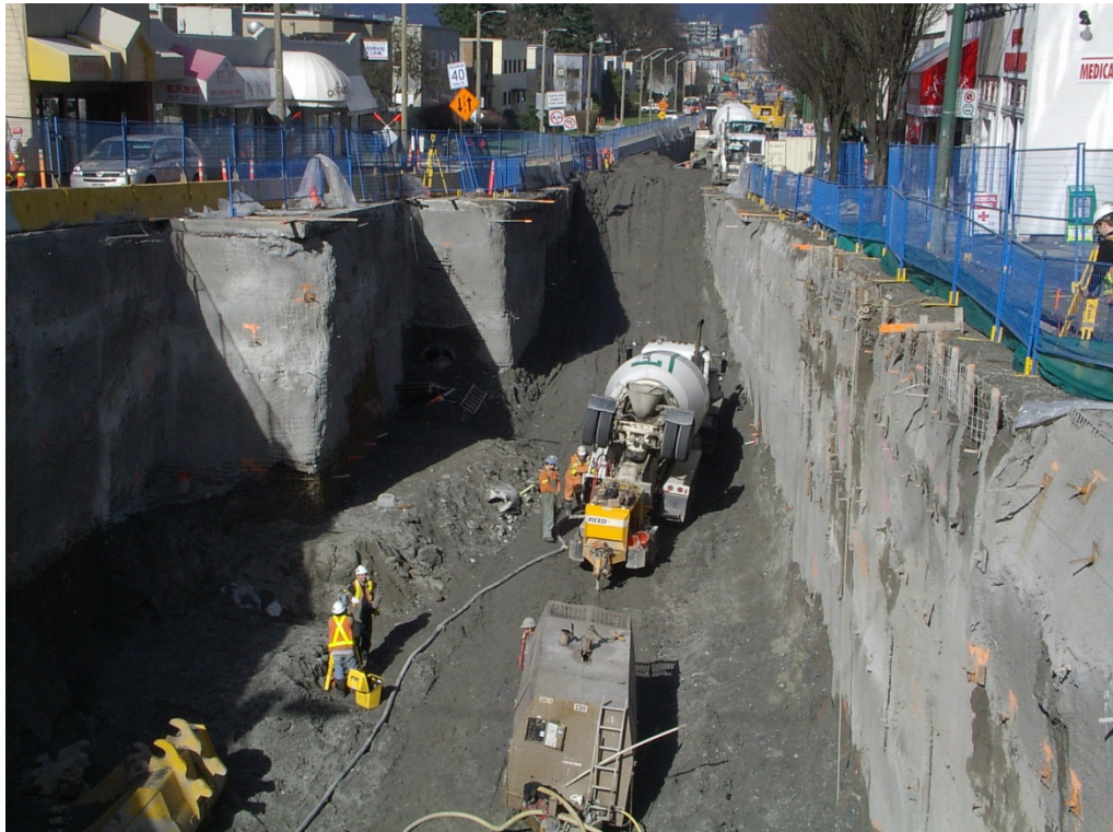
Figure 7-50 : Exemple de construction en tranchée couverte - Skytrain de Vancouver (4)
