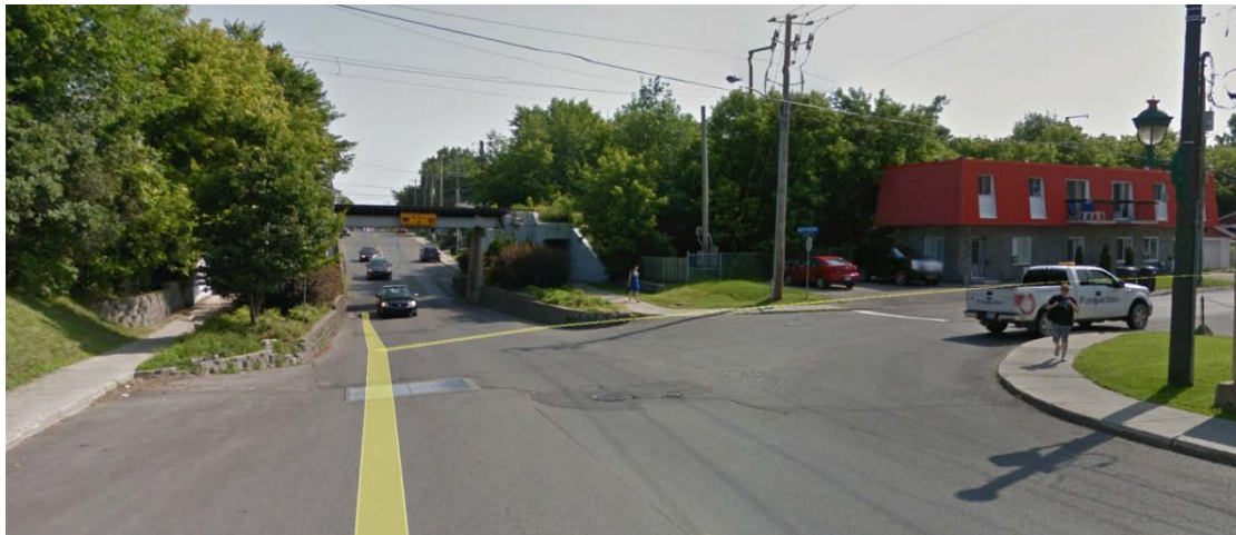
Figure 7-25 : Ouvrage d'art - pont d'étagement - chemin d'Oka
