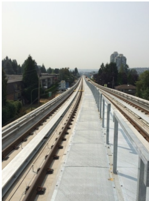
Figure 7-59 : Exemple de chemin d'évacuation tracé en surélevé (Evergreen Line - Vancouver)
