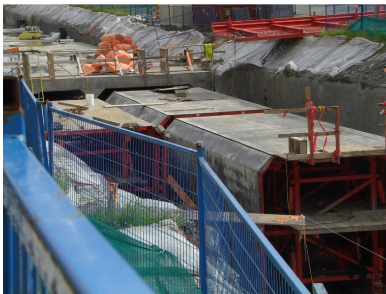
Figure 7-41 : Exemple de configuration en tranchée couverte (2)
