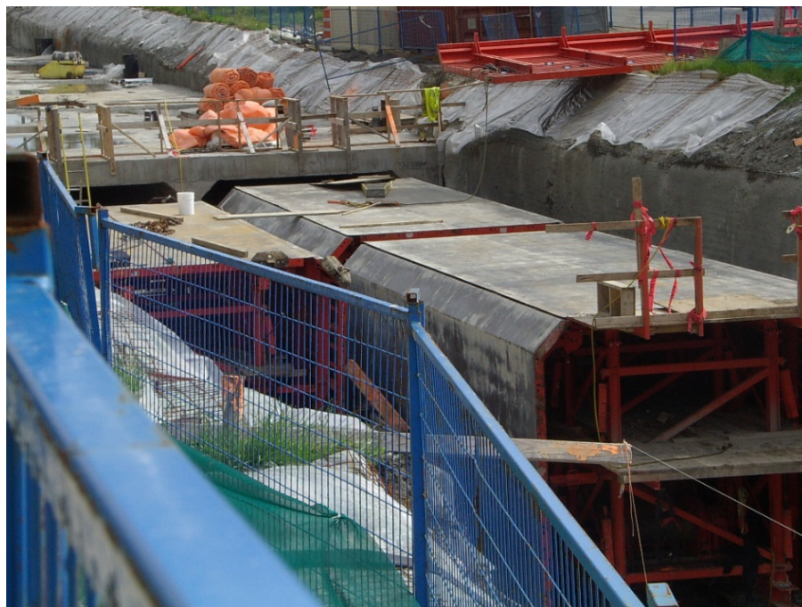
Figure 7-48 : Exemple de construction en tranchée couverte - Skytrain de Vancouver (2)
