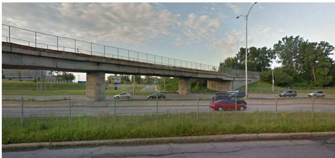
Figure 7-18 : Exemple d'étagement de voie ferrée (2)
