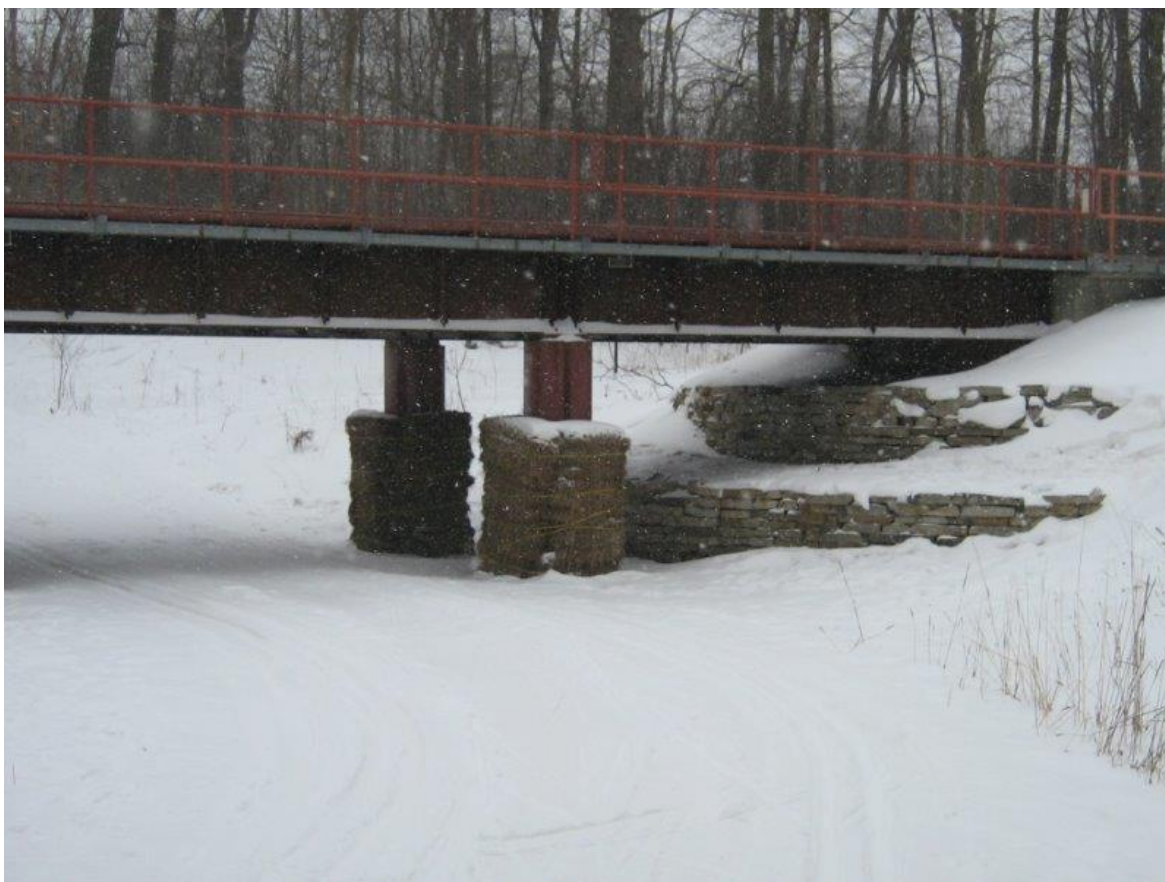
Figure 7-26 : Ouvrage d'art - pont d'élévation - sentier du Bois-de-Liesse
