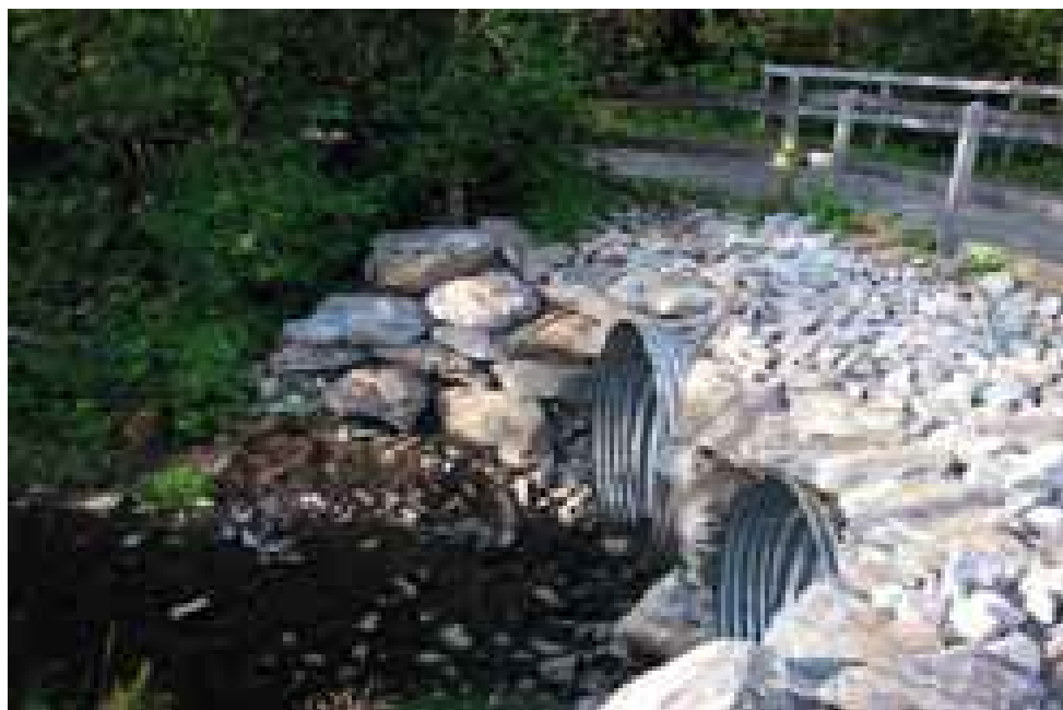
Figure 7-58 : Exemple de construction avec remblai et ponceaux
