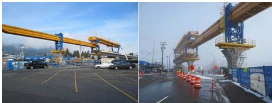
Figure 5-26 : Technique envisagée pour la pose des voussoirs
