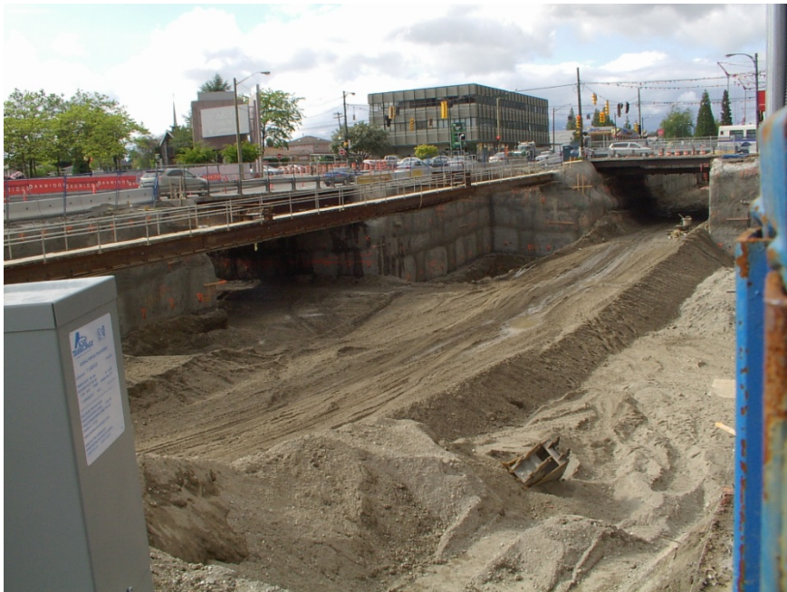
Figure 5-29 : Exemple de construction en tranchée couverte - Skytrain de Vancouver (3)
