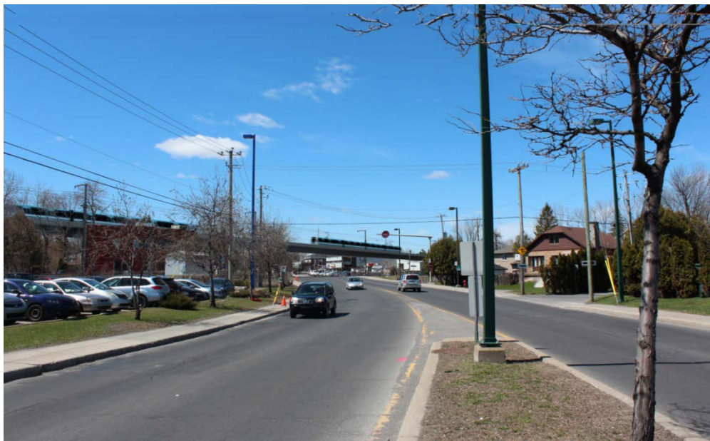
Figure 6-5 : Simulation viaduc ferroviaire au boulevard Gouin– Vue intersection rue Meighen vers le nord-ouest
