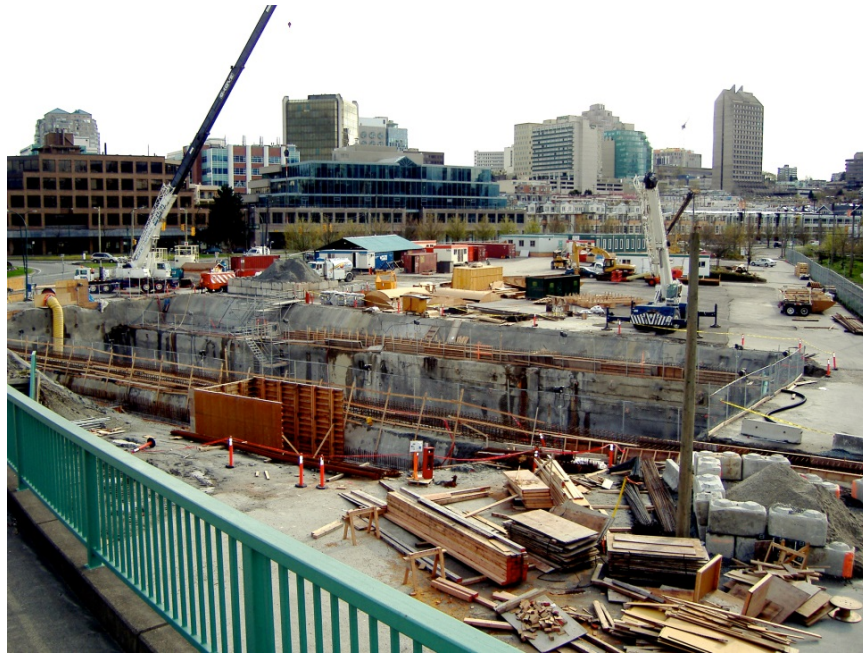
Figure 5-27 : Exemple de construction en tranchée couverte - Skytrain de Vancouver (1)
