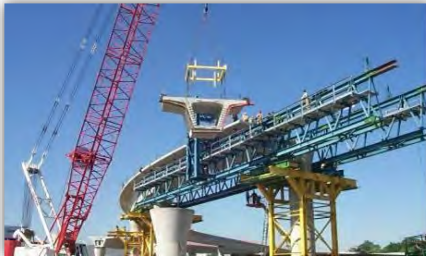
Photographie 7-14 – Installation à la grue avec une poutre de pose
