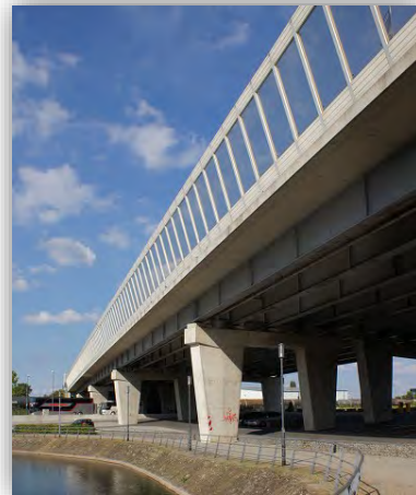
Poutres en acier (Hafenbahnbrücke, Allemagne) (Source : www.structurae.info )
