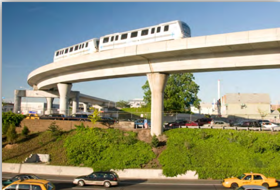
Monocaisson en béton précontraint (Airtrain, JFK New-York) (Source : www.figgbridge.com )
