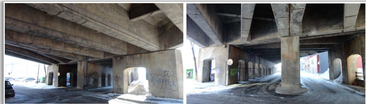
Photographie 7-11 – Structure du pont d'étagement du CN
