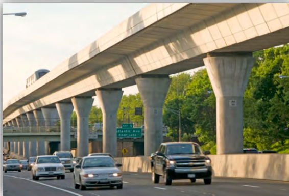
Piles à colonnes uniques (Airtrain, JFK New York)
