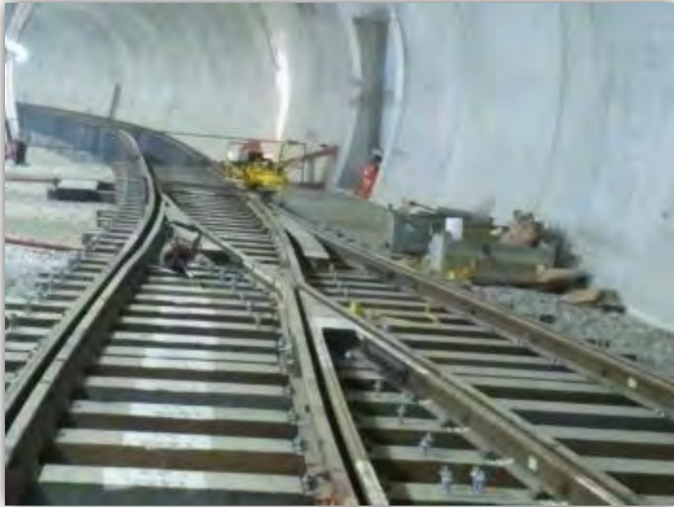
Photographie 7-1 – Exemple d'appareil de voie
