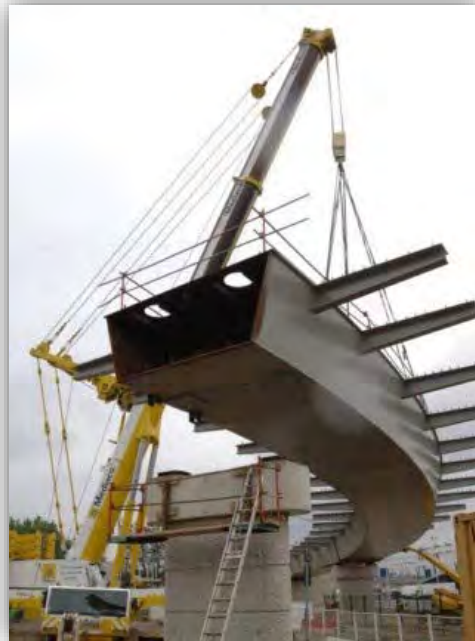
Photographie 7-15 – Exemple de monocaisson mis en place à la grue
