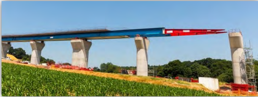
Photographie 7-16 – Exemple de charpente en acier mise en place par lançage
