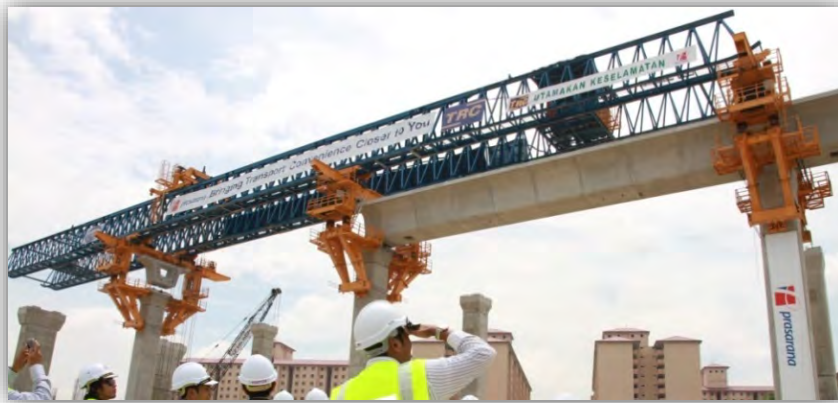
Photographie 7-13 – Voussoirs suspendus à la poutre de pose
