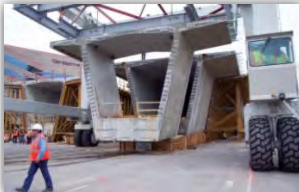
Photographie 7-12 – Ligne de préfabrication de voussoirs
