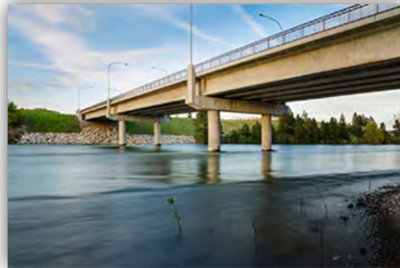
Pile à doubles colonnes (Appleway Bridge, É.-U.)
