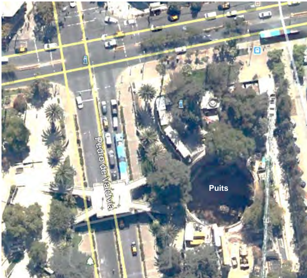
Photographie 6.3.a.- Site du chantier pour la construction de la station Inés de Suarez de la Ligne 6 du métro de Santiago du Chili.
