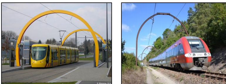
Figure 2-9 : Exemples d'arches supports de caténaire
