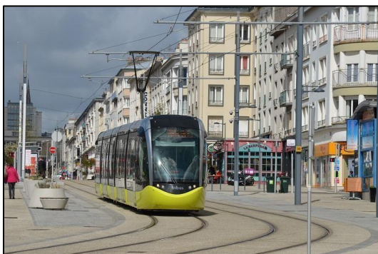
Figure 2-4 : Ligne aérienne de contact (LAC)
