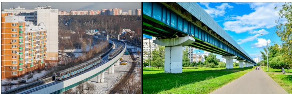
Figure 2-18 : Vues de certaines sections aériennes et surélevées du métro de Moscou
