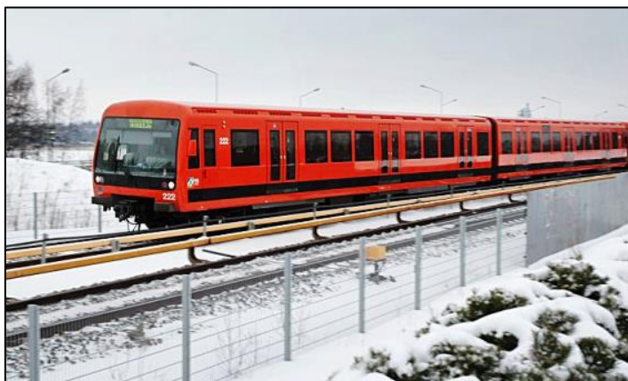
Figure 2-21 : Métro de Helsinki sur une portion en surface
