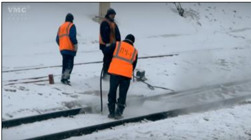
Figure 2-20 : Déneigement manuel requérant un nettoyage plus précis sur le réseau du métro de Moscou
