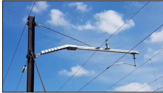
Figure 2-13 : Armement du projet ACCUM porté par la SNCF, Stratiforme Industries, le Centre d'essais ferroviaires de Valenciennes et l'IMT Lille Douai
